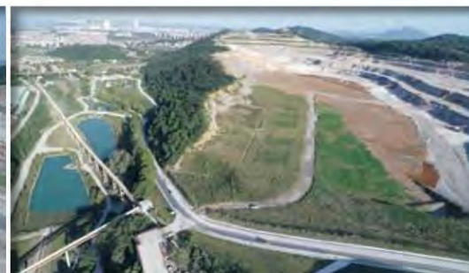
码头灰岩矿暂开采区域覆土植绿 (2020年)
