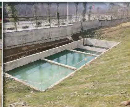
大仓边新建三级沉淀池
