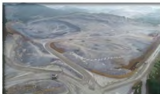
新屋田灰岩矿暂开采区域 (2019年)
