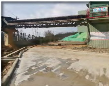
生活区到大仓道路硬化
