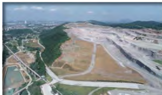
码头灰岩矿暂开采区域覆土植绿 (2019年)
