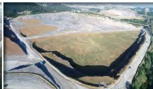
新屋田灰岩矿暂开采区域 (2020年)
