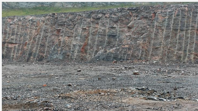
终了边坡实施预裂爆破，维持岩体完整及稳定性
